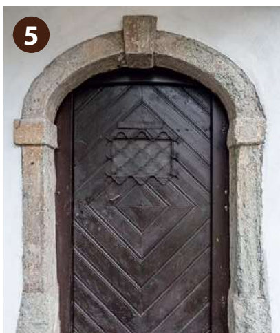
Hiša ima ohranjen pozno-baročni portal iz zelenega tufa in poznogotski kamniti kletni portal. Jože Markeš je bil elektrotehnik in inovator, v domove je pripeljal žarnice in sestavil sončni kolektor.
