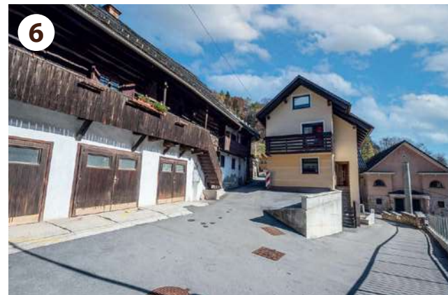
Dve ohranjeni kajžarski hiši z zidanim pritličjem, lesenim nadstropjem in gankom. Na Murovi 18 je bila leta 1825 prva jeseniška (Janezkova) šola.
