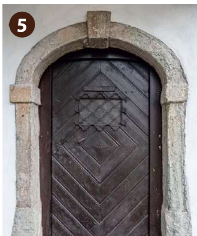
Hiša ima ohranjen pozno-baročni portal iz zelenega tufa in poznogotski kamniti kletni portal. Jože Markeš je bil elektrotehnik in inovator, v domove je pripeljal žarnice in sestavil sončni kolektor.
