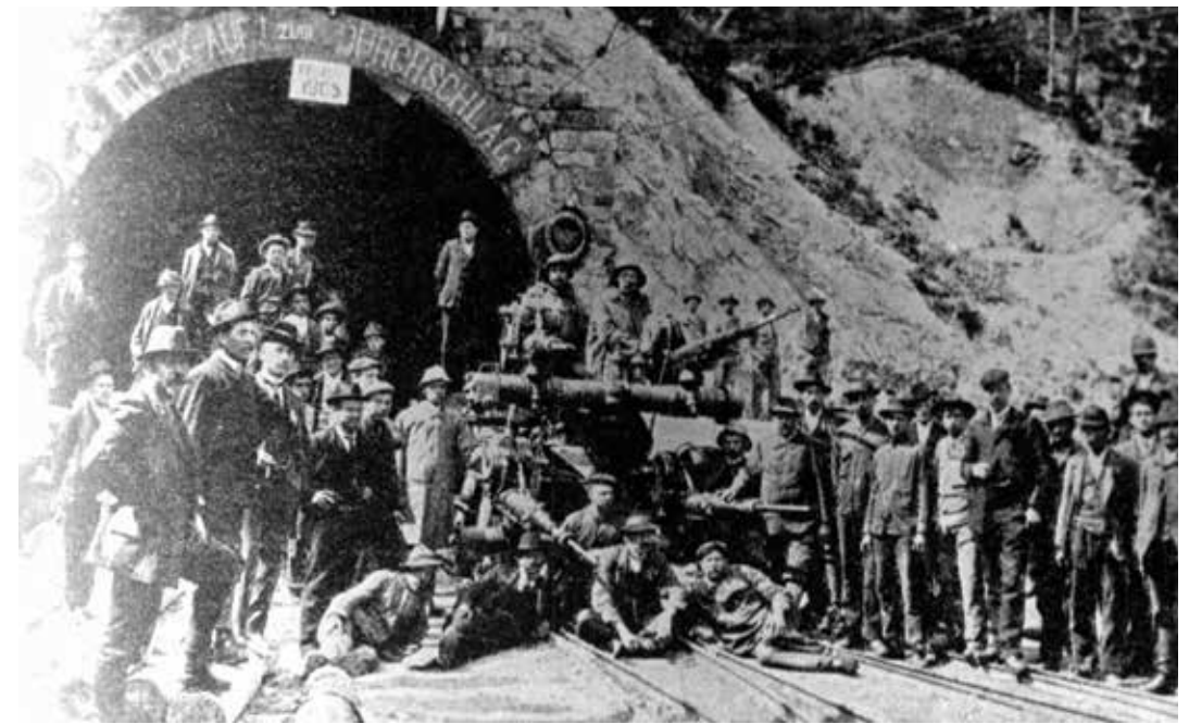
Delavci proslavljajo prebitje karavanškega predora na Karavanško-Bohinjski železnici leta 1905. Workers celebrating the breakthrough of the Karavanke Tunnel on the Karavanke-Bohinj railroad, 1905.
